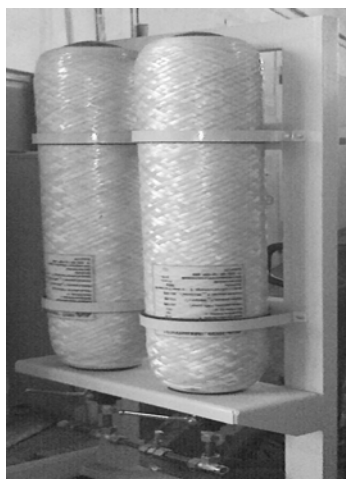
Рисунок 3 – Блок баллонов комбинированных универсальных БКУ-40-350С. ТУ 2296-030-18074387-2006
